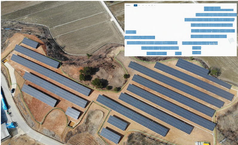
나대지 1MW (경북 상주, 2024 준공)
